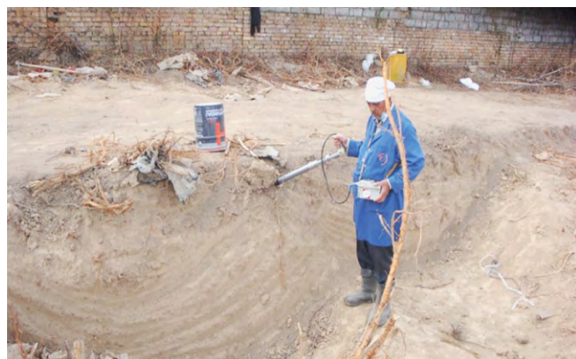
Рис. 3. Выемка загрязненных грунтов и их дозиметрический контроль
