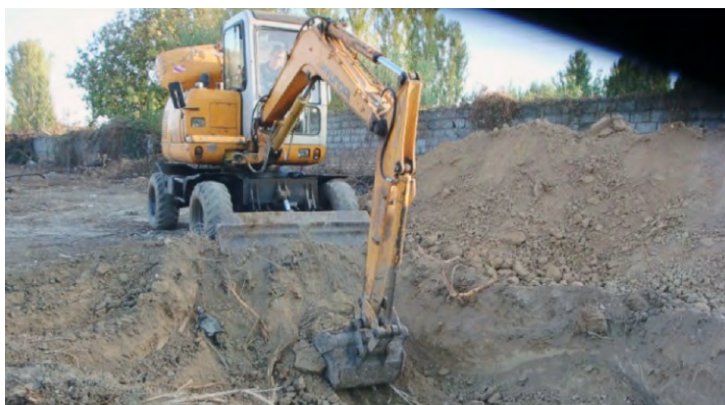
Рис. 3. Выемка загрязненных грунтов и их дозиметрический контроль
