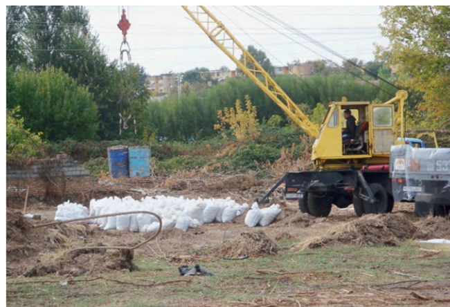
Рис. 4. Упаковка и складирование твердых радиоактивных отходов
