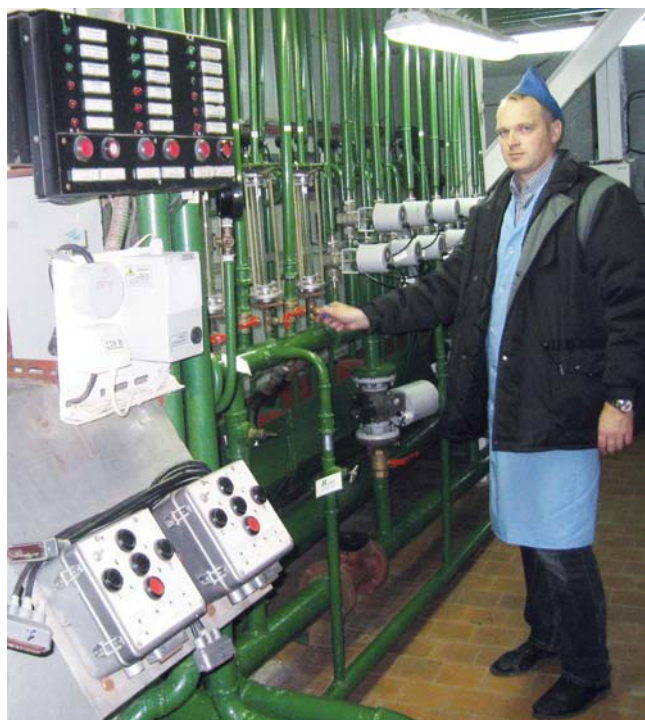
Установка остекловывания жидких РАО. Настройка системы охлаждения плавителя / Facility of the vitrification of liquid radioactive waste. Setting up the cooling system of melters
