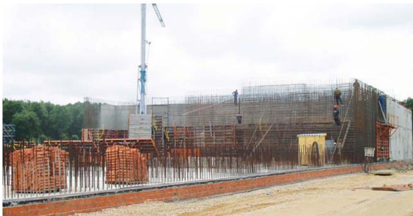
Возведение первых модулей наземного хранилища РАО Construction of first units of the overground final isolation storage
