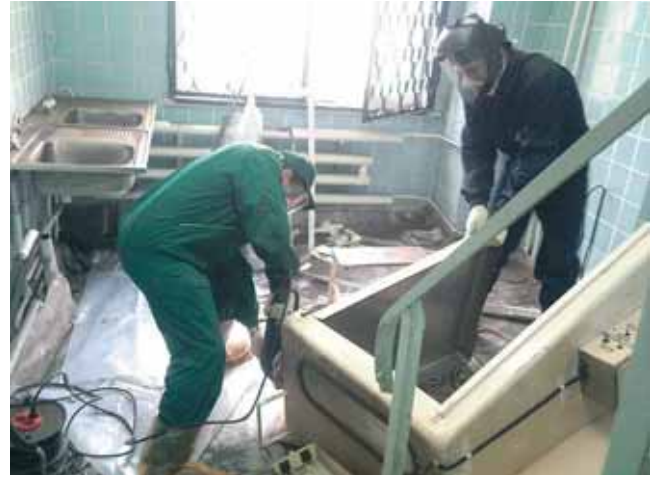
Демонтаж крупногабаритного оборудования, загрязненного радиоактивными веществами, радоновой лаборатории поликлиники Центрального региона России. МЭД ГИ - 106000 мкР/ч / Dismantling of large-sized equipment which is contaminated by nuclear materials in the hospital radon laboratory in the central Russian region. Equivalent gamma-ray dose – 106000 mkr/h
