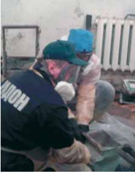
Дезактивация очагов радиоактивного загрязнения в помещениях радоновой лаборатории поликлиники Центрального региона России. МЭД ГИ – 6240 мкР/ч / Decontamination of the contaminated radioactive area in the buildings of radon laboratory in the central Russian region. Equivalent gamma-ray dose – 6240 mkr/h
