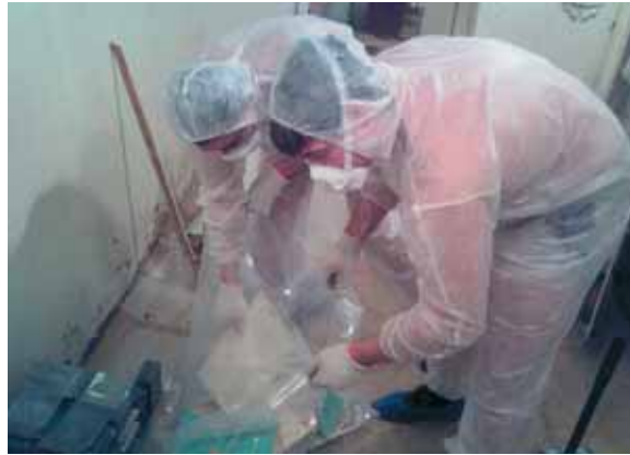
Дезактивация очагов радиоактивного загрязнения в помещениях радоновой лаборатории поликлиники Центрального региона России. МЭД ГИ – 6240 мкР/ч / Decontamination of the contaminated radioactive area in the buildings of radon laboratory in the central Russian region. Equivalent gamma-ray dose – 6240 mkr/h
