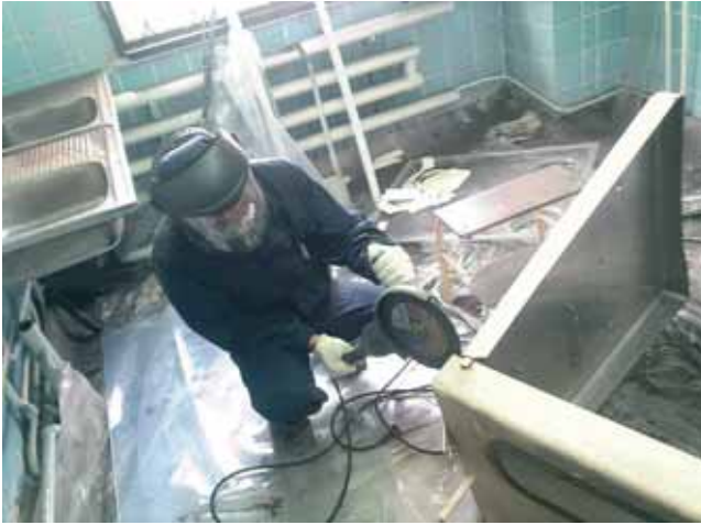
Демонтаж крупногабаритного оборудования, загрязненного радиоактивными веществами, радоновой лаборатории поликлиники Центрального региона России. МЭД ГИ - 106000 мкР/ч / Dismantling of large-sized equipment which is contaminated by nuclear materials in the hospital radon laboratory in the central Russian region. Equivalent gamma-ray dose – 106000 mkr/h
