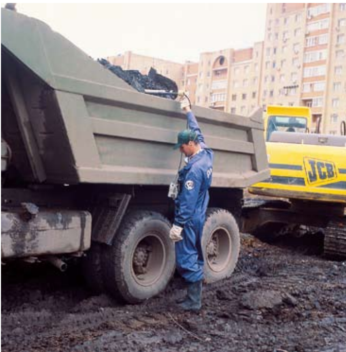
Измерение загрязнения радиоактивного грунта Measuring of contaminated soil
