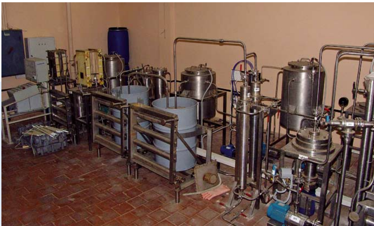
Установка для очистки жидких радиоактивных отходов Installation for liquid radwaste processing
