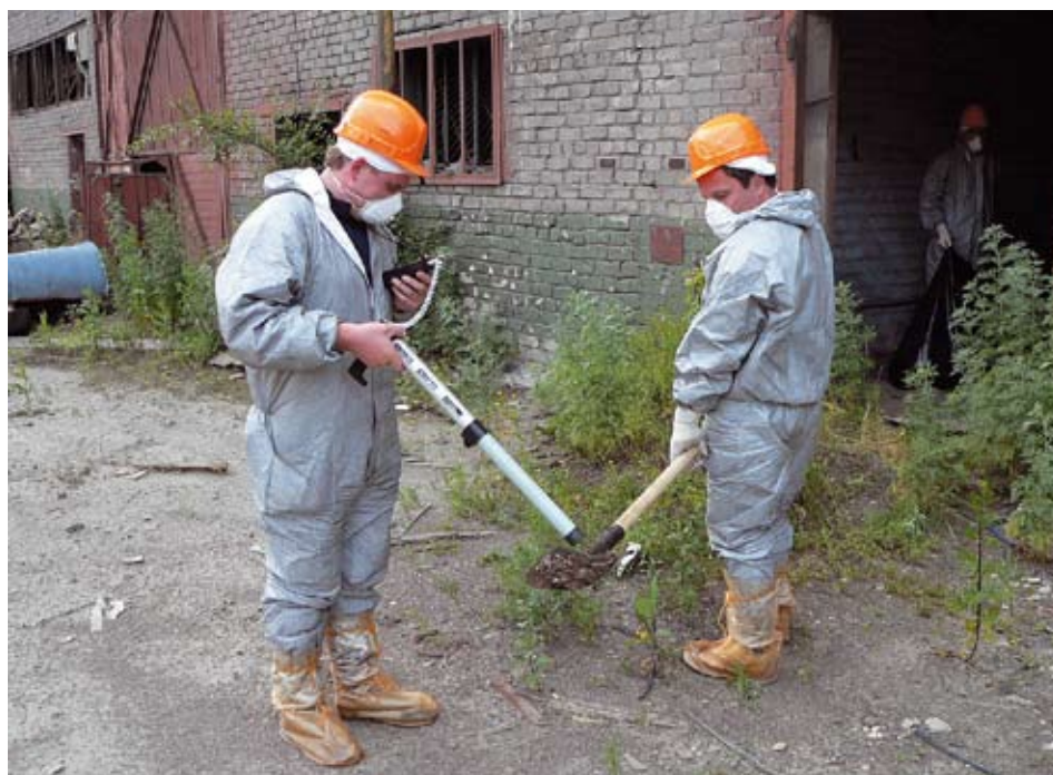
Ремедиационные работы на загрязненной территории Remediation of a polluted site
