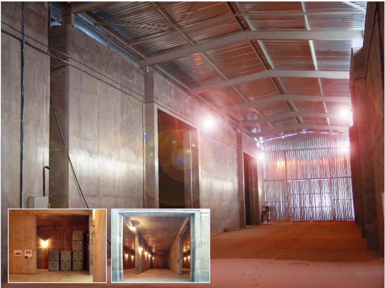
Наземное сооружение бункерного типа для хранения кондиционированных форм РАО A bunker type surface building for conditioned radwaste storage
